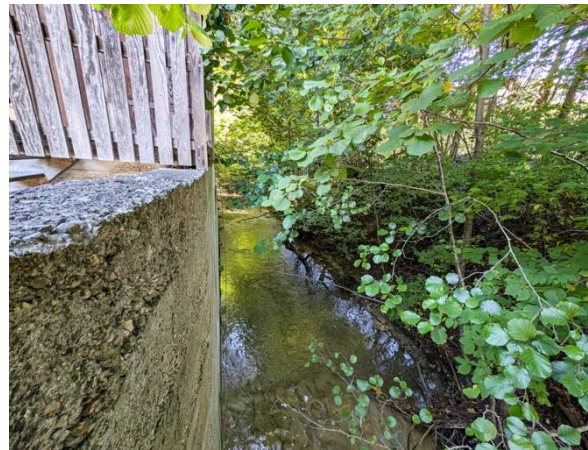
Blick an Stall / Remise vorbei in den Wald
