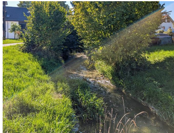
Blick nach Südwesten bei Abschnittsmitte
