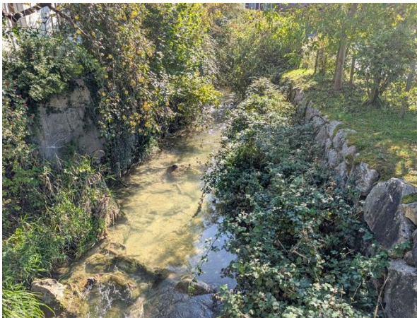
Südblick Brücke Hinterdorfstrasse
