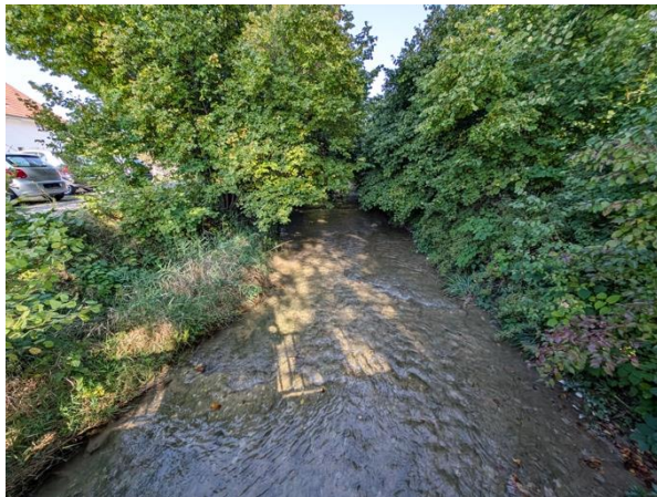
Nordblick von Brücke Alte Horgenbachstrasse
